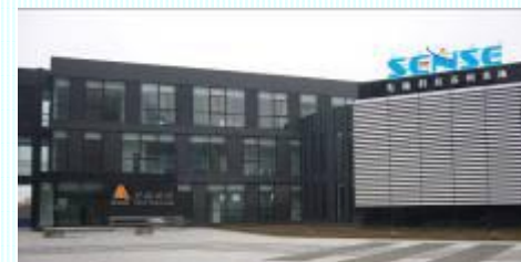
苏州生产基地及应用示范工程中心
