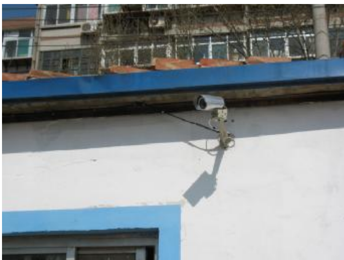
高速红外摄像机（拍摄出门车辆整体情况）
