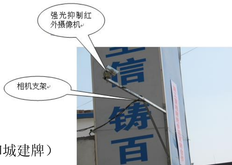
高速红外摄像机（拍摄出门车辆整体情况）
